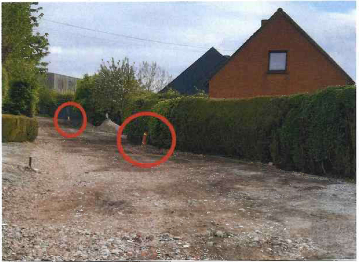
Photo 3 (raccordements en attente)
